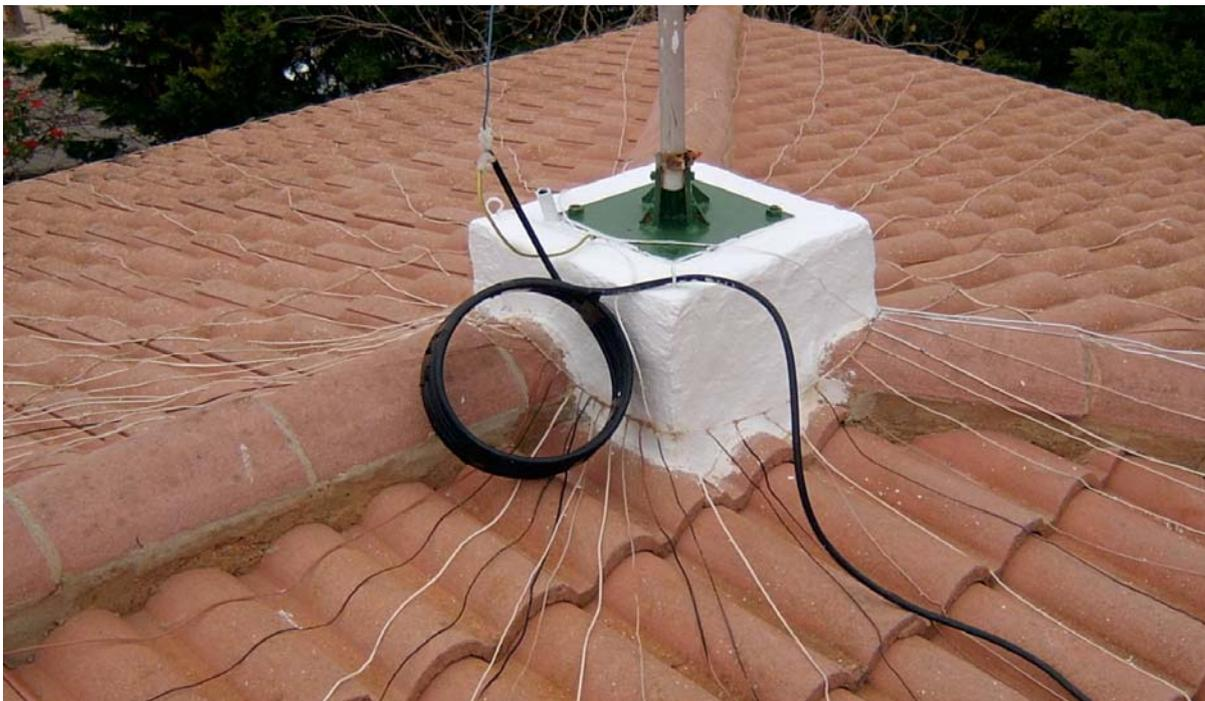
Con 64 radiales el porcentaje se situaba en 98% y sobre el 96% para 32. A medida que la base de la antena se eleva sobre el terreno menos radiales serán necesarios para mantener la eficiencia, de forma que a 0,05 longitudes de onda sobre el suelo (unos 4 m. en la banda de 80m) con pocos radiales se obtendrán elevadas eficiencias.
