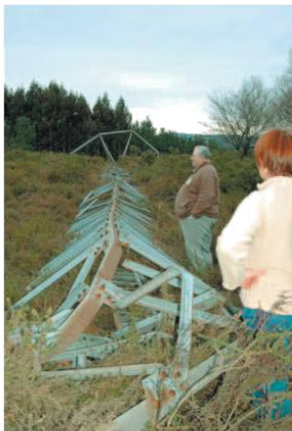
La torre, de 110 metros, partió por la mitad y se vino abajo
